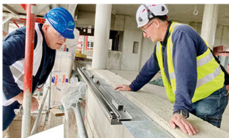
Feldhaus Obermonteur Ewald Schmidt (r., „Der Erfahrenste, den wir haben“) und Gargiulo Vertriebsleiter Marcus Müller nehmen die Positionierung für das Insufox Profil in Augenschein.
