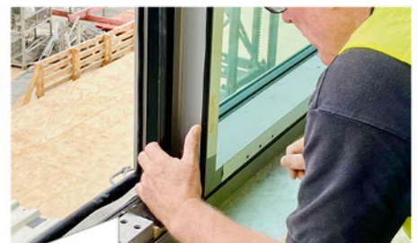
Wie berichtet, werden die stattlichen Elemente zum Teil auch auf die Insufox Profilgeometrien abgelastet. Das PET-Material, das sich für jedes Fenstersystem adaptieren lässt, ist hochdruckfest.
